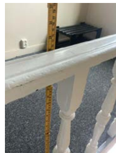
Rekkverk rundt trappeåpning i etasjeskiller - 72 cm
