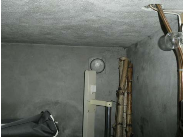
Rør av kobber - eldre dato.
