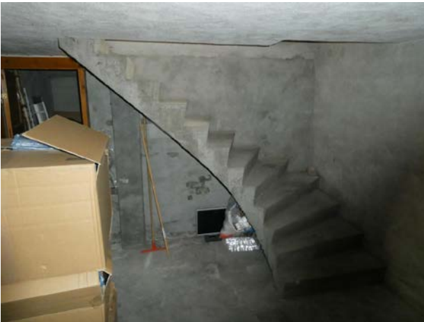
Trapp mellom kjeller og 1.etasje
