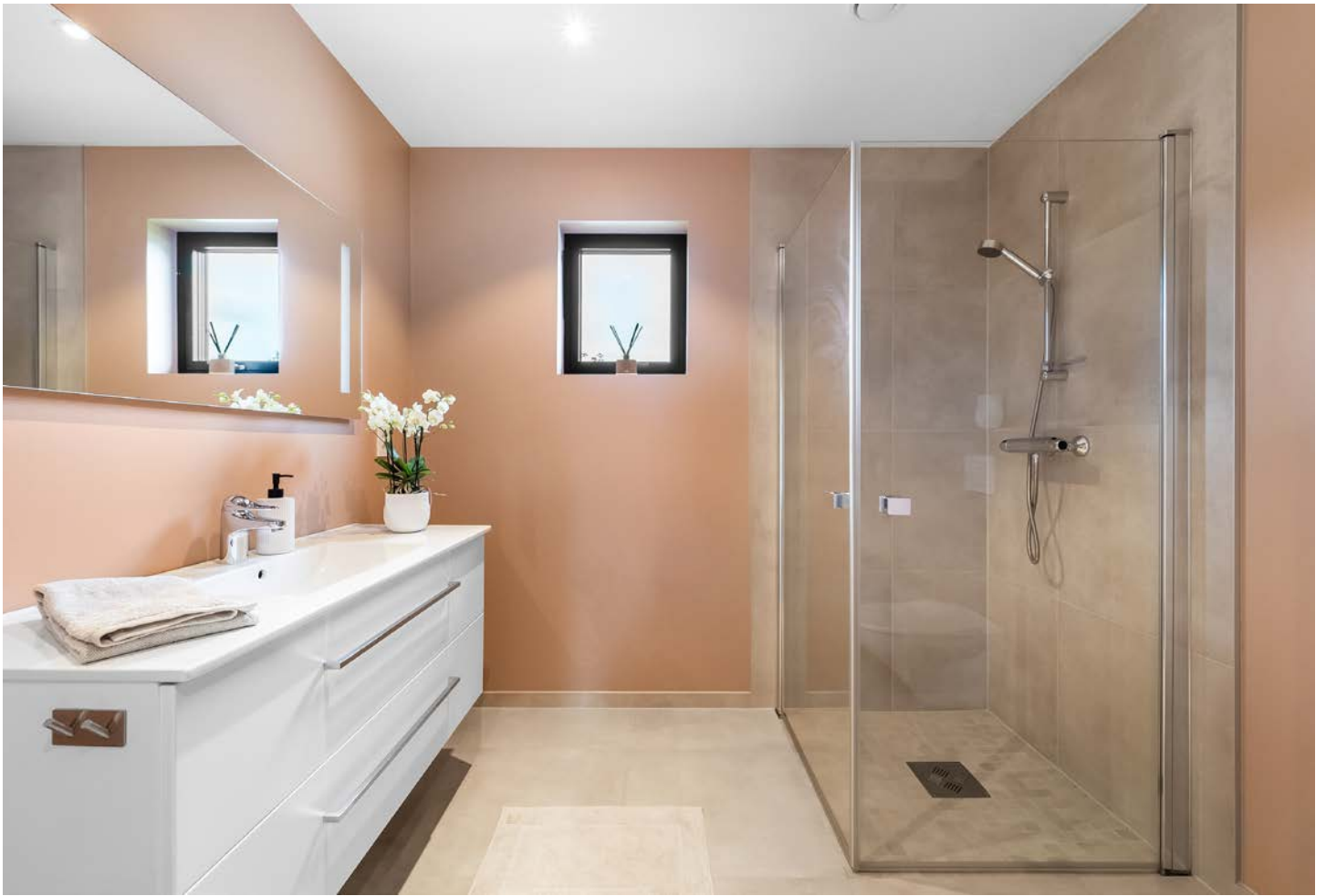
Bad i 1. Etasje har gipsplater på vegg og fliser på gulv og i dusjsone.
