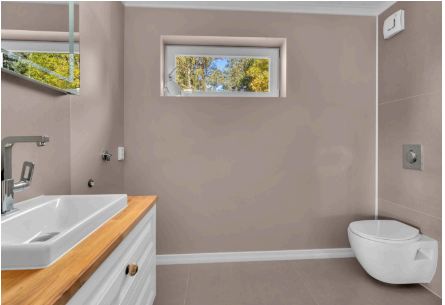
Badet har flislagt gulv med varmekabler.
