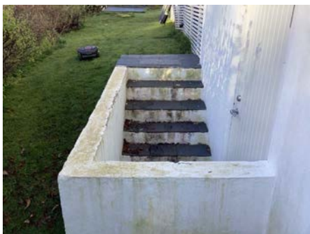
Trapp har ikke rekkverk
