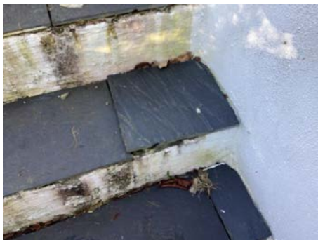
Trapp har ikke rekkverk
