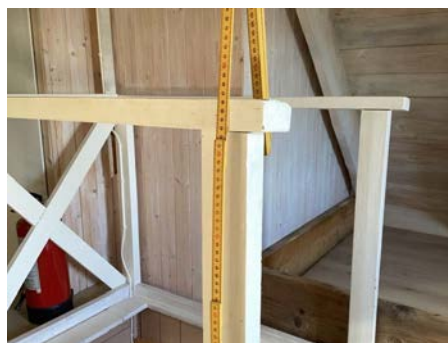
Store åpninger i rekkverk
