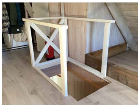
Store åpninger i rekkverk
