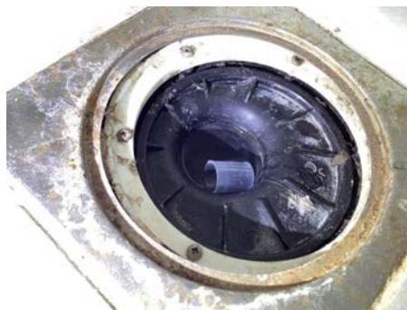
Ukjent membran / tettesjikt i sluk under badekar
