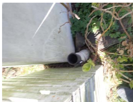
Nedløp for takvann i grunn.
