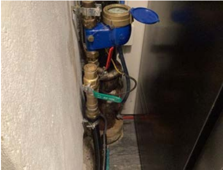
Ny vannledning og stoppekran i kjeller
