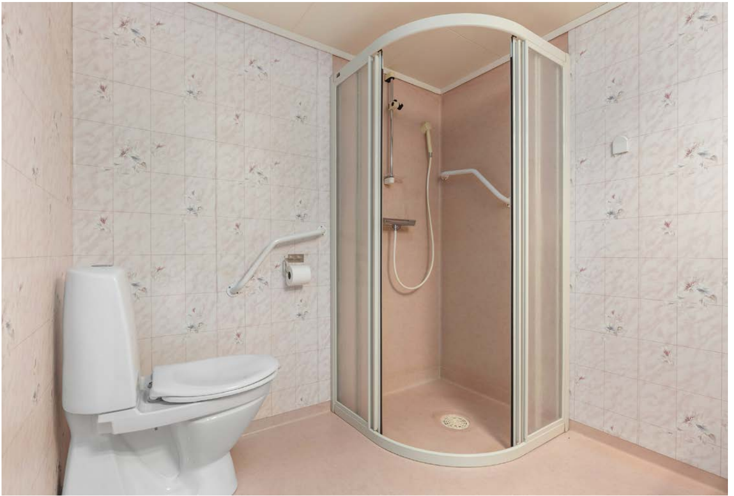
Bad med dusjhjørne, toalett og baderomsinnredning med servant
