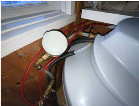
Vannmåler og utsnitt rør-i-rør.
