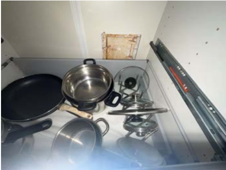
Feieluke bak kjøkkeninnredning.
