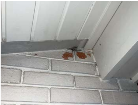
Misfarge og maling som flasser på pipe.
