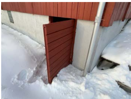
Ytterdør mot krypkjeller.
