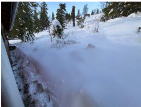
Terreng har fall mot konstruksjon på nordsiden.
