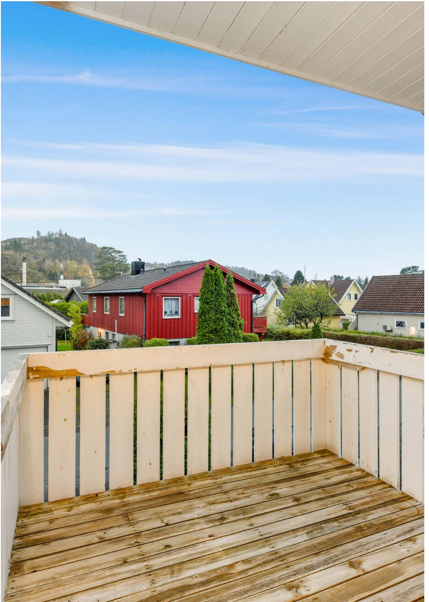
Utgang til veranda fra stuen, ligger mot sør.
