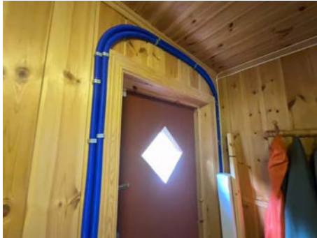
Utsnitt rør-i-rør.
