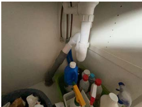
Avløpsrør i plast.
