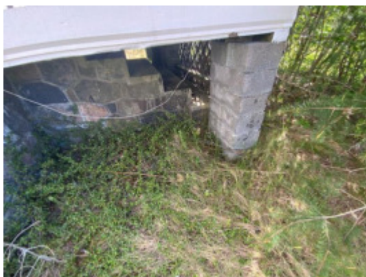
Fundamenter av Leca som ikke er slemmet/fuktsikret.
