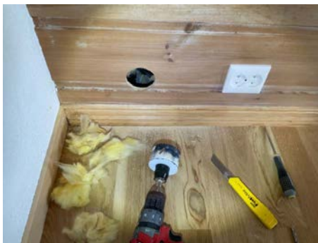
Hullboring utført i stuedel. Ingen unormale forhold registrert
