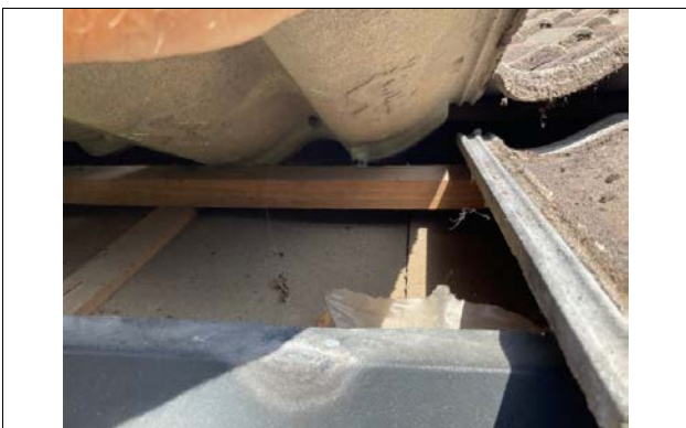
Stikkontroll av undertak, normal alderslitasje registrert
