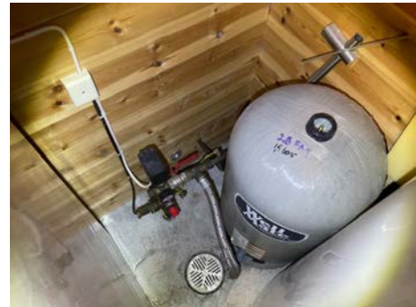
Stoppekran og trykktank i utleiedel
