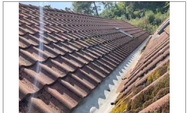
Renne mellom takene på båthusene
