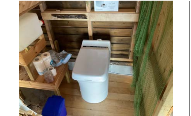
Forbrenningstoalett montert. Ikke testet/sjekket
