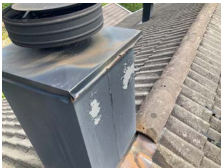
Slitasje i form av avskalling av plastbelegg
