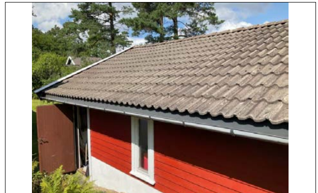
Taktekking fra byggetid
