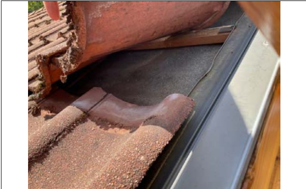
Stikkontroll av undertak fra takvindu
