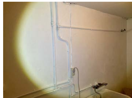
Rørproppleg i opprinnelig del fra 1981
