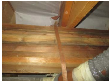
Luftet over tak.
