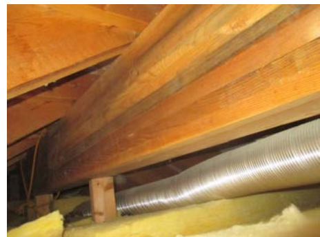
Deler av takkonstruksjonen.
