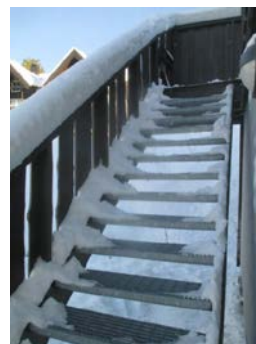
Utvendig trapp til andre etasje.
