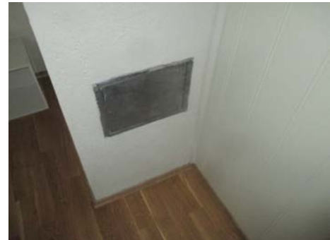
Sotluke på ene soverommet.
