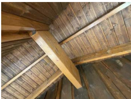
Del av takkonstruksjon.
