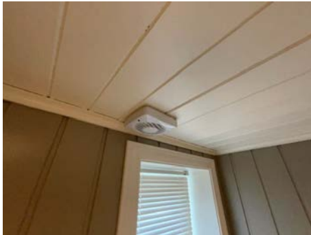
Montert avtrekk i tak.
