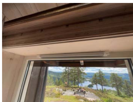
Eksempel på montert ventil i vindu.
