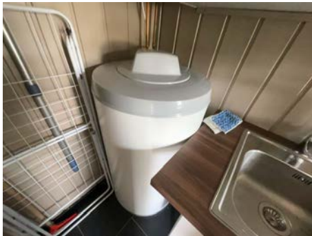
Varmtvannstank.
