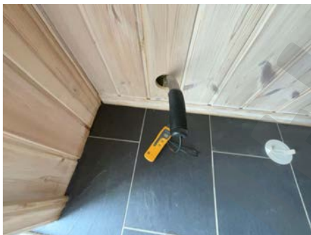
Hull for kontroll av fukt.
