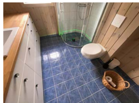
Målt fall på gulv.
