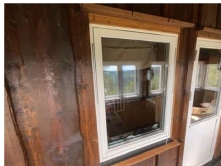
Eksempel på vindu i yttervegg.
