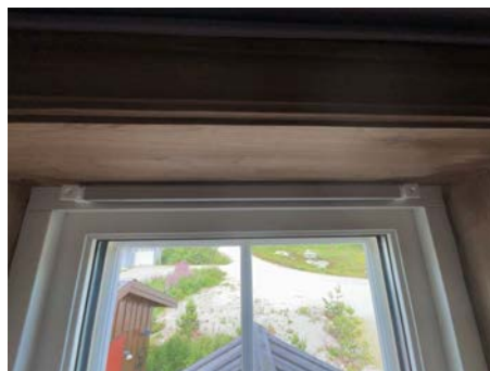
Eksempel på montert ventil i vindu.
