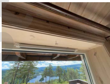
Eksempel på montert ventil i vindu.
