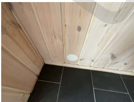
Hull for kontroll av fukt.
