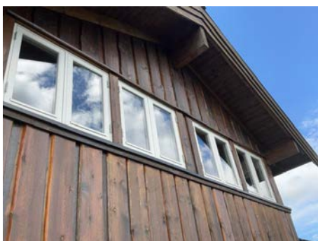
Eksempel på vindu i yttervegg.
