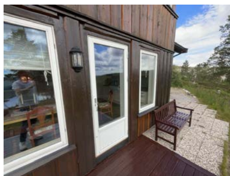
Terrassedør inn til kjøkken.
