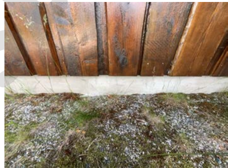
Del av grunnmur.
