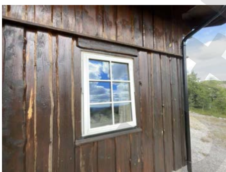
Eksempel på vindu i yttervegg.
