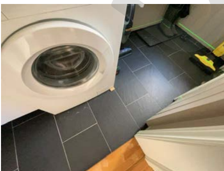
Målt fall på gulv.
