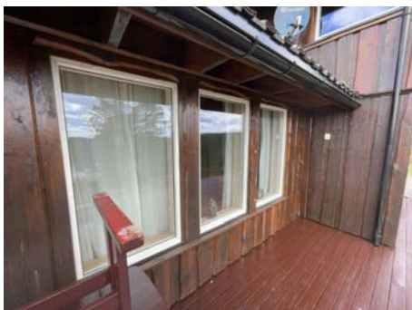
Eksempel på vindu i yttervegg.
