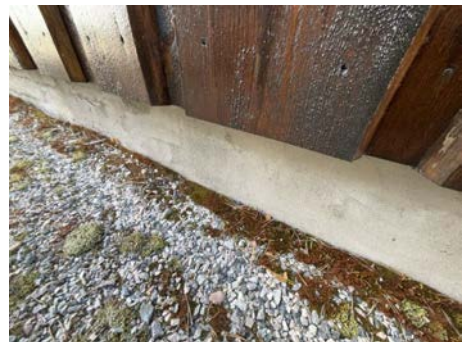
Del av grunnmur.
