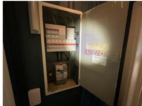
Sikringskap er oppgradert med automatsikringer.
