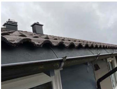
Takrenner fra byggetiden
