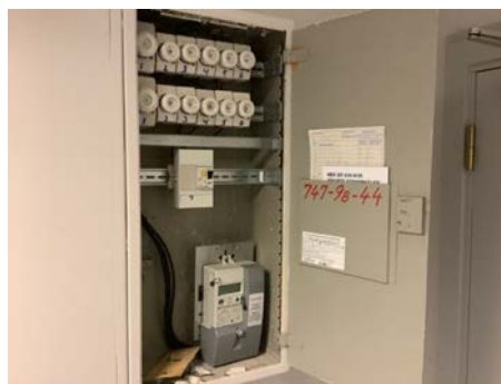
Sikringsskap står montert i fellesgang.
