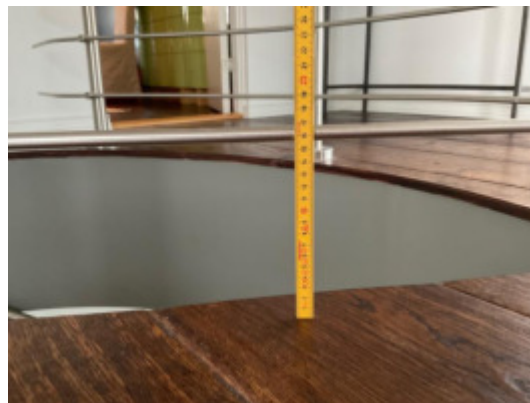
Rekkverk i 3. etg.
