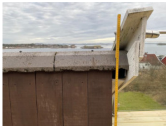
Rekkverkshøyde ca 82cm.
