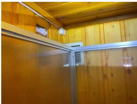
Bilde viser eks. på koblingsboks i dusj/våtsone
