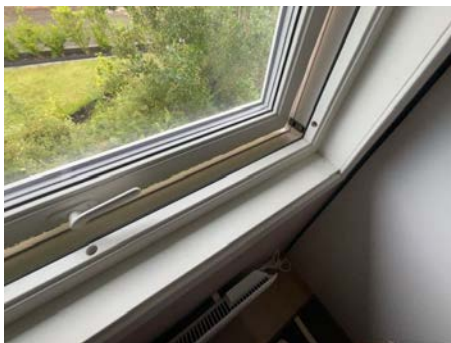
Bilde viser eks. på manglende vindus-/karmpropper
