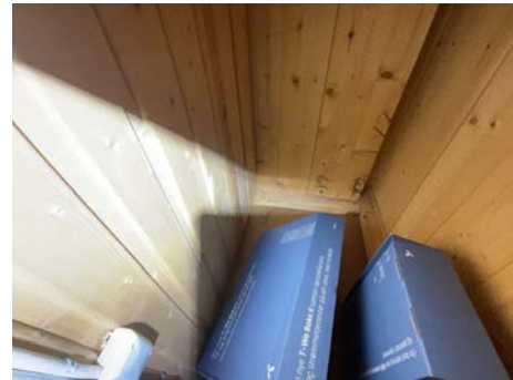
Bilde viser eks. på åpen konstruksjon bak baderommet i skap fra gang.
