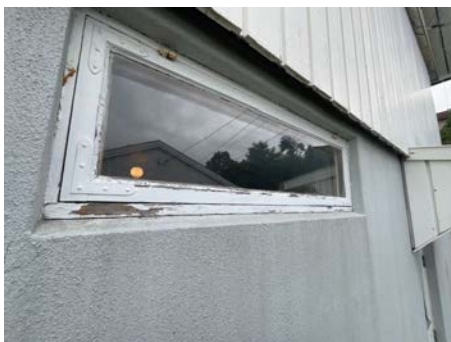
Bilde viser eks. på manglende vindus-/karmpropper
