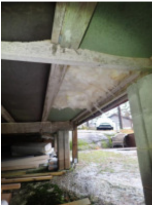
Mangler plate i stubbegolv.
