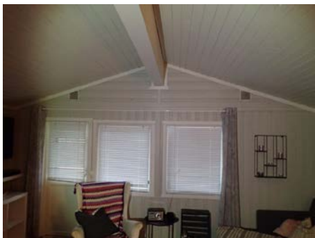
Gjenbygget konstruksjon til møne
