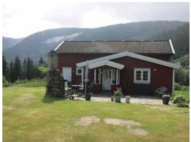
Våningshus fra 1800 t. med påbygg fra 2005, sett fra nord.
