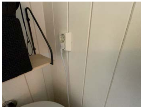
Varmtvannstank fra 2019 tilkoblet vanlig stikkontakt (krav til fast punkt)
