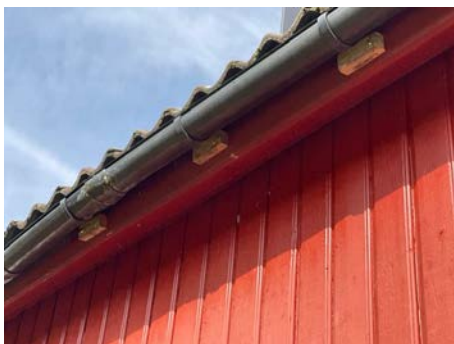
Bilde viser renne som er støttet opp med treklosser
