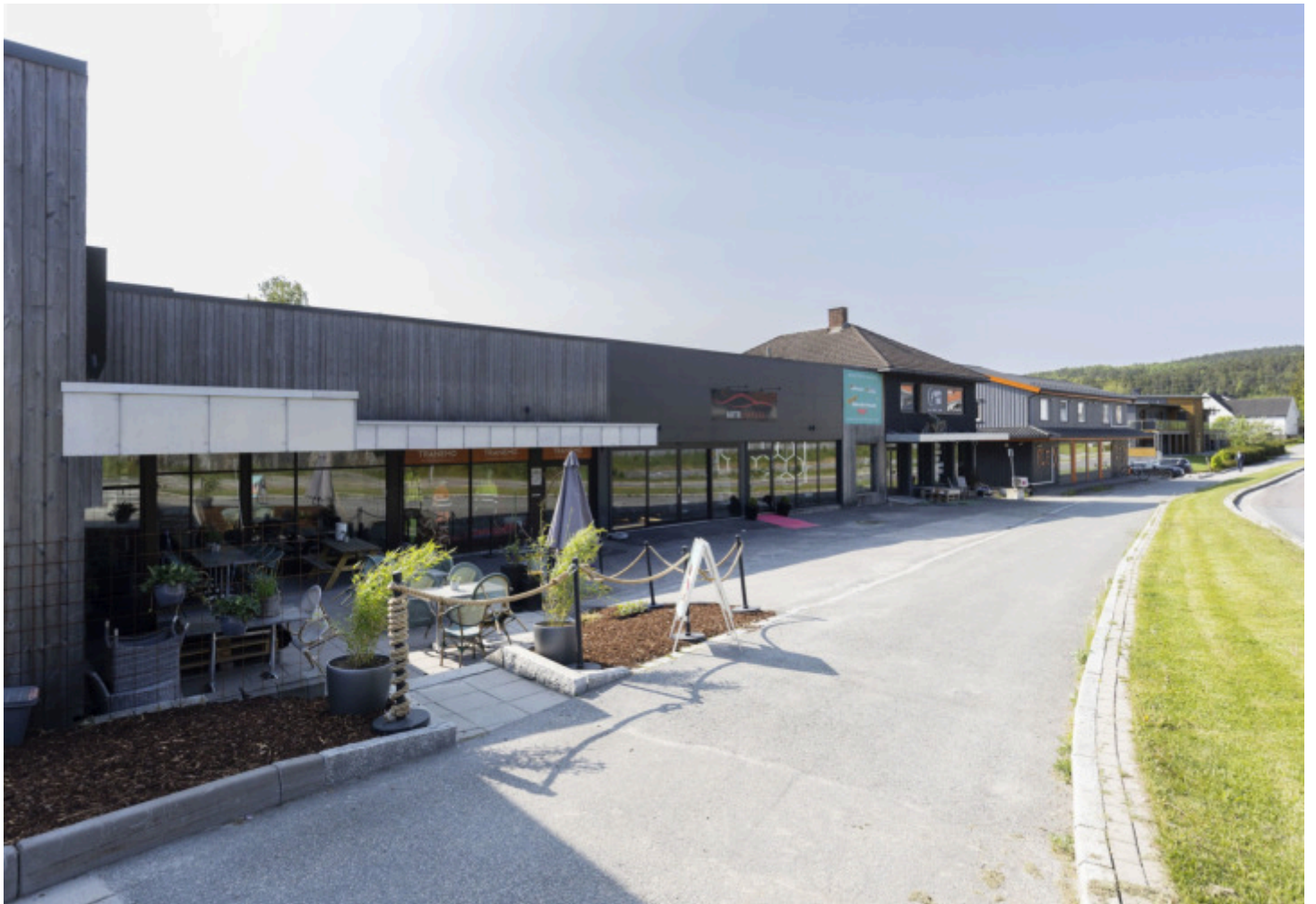
Over eiendommen ligger Heistad Marked som idag huser flere forretninger - Deriblant Banken Cafe.
