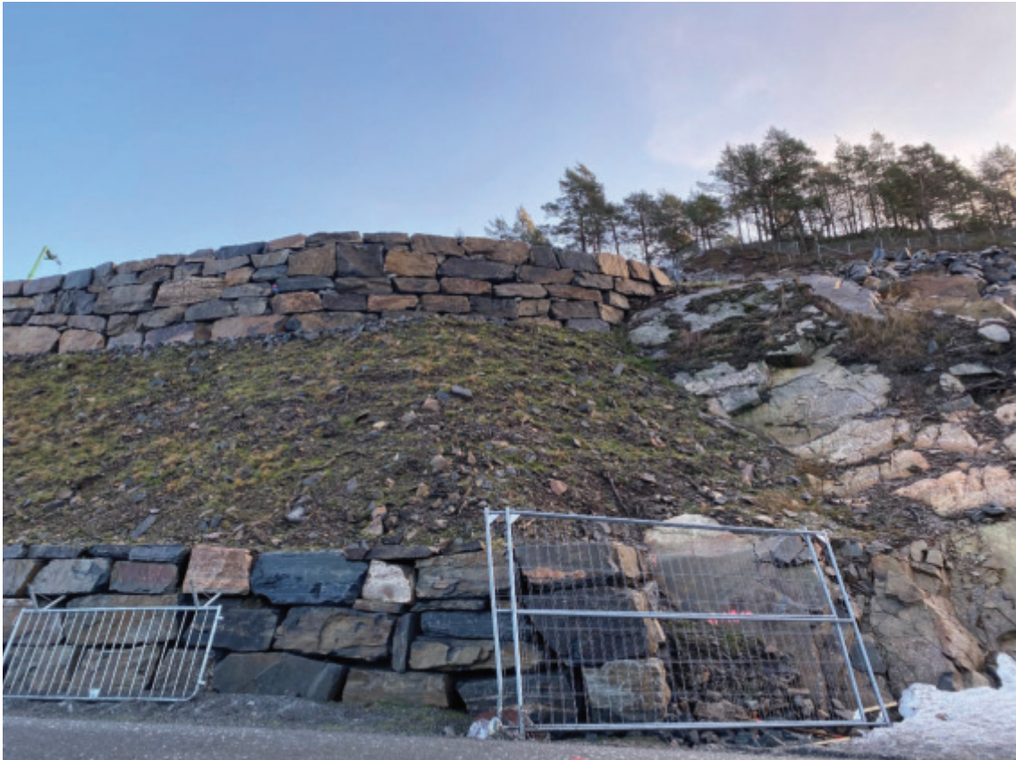
Skråning og mur som er etablert ved tomt 21.
