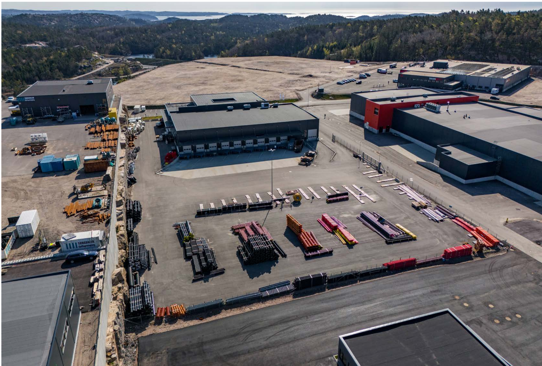
Oversikt over eiendommen sett fra nord
