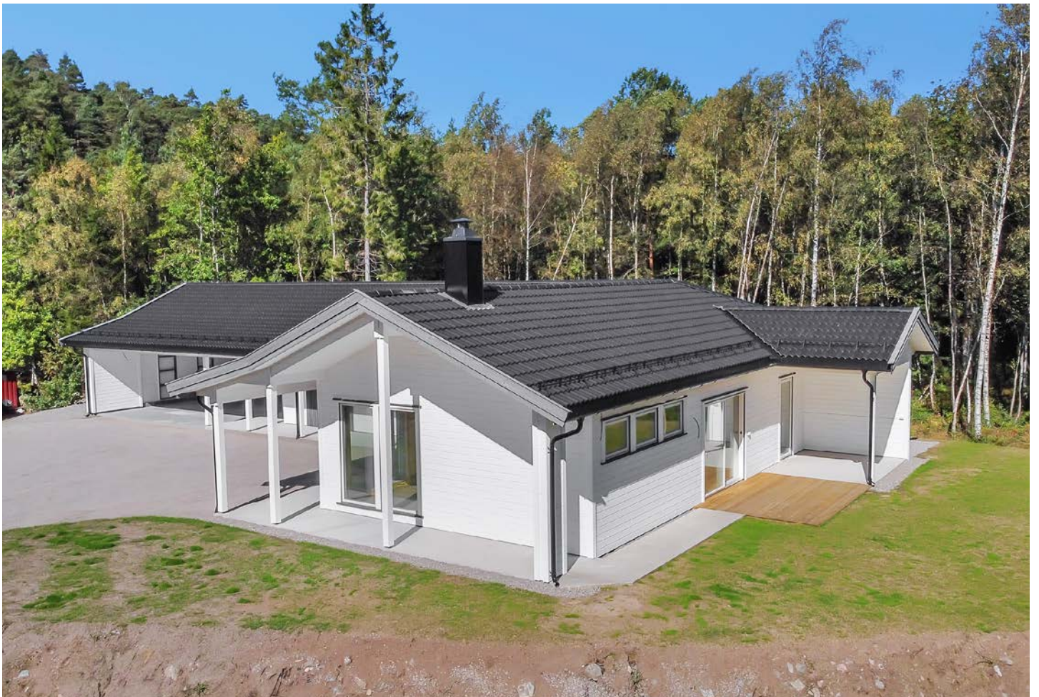
Det er støpt ringmur fra carport og rundt bolig
