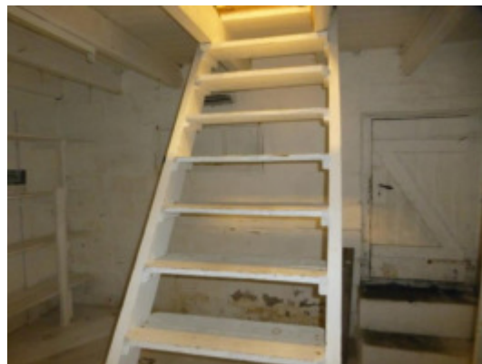
Kjellertrapp tilbygg, fra luke i gulvet.
