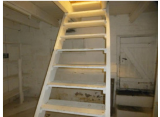
Kjellertrapp tilbygg, fra luke i gulvet.
