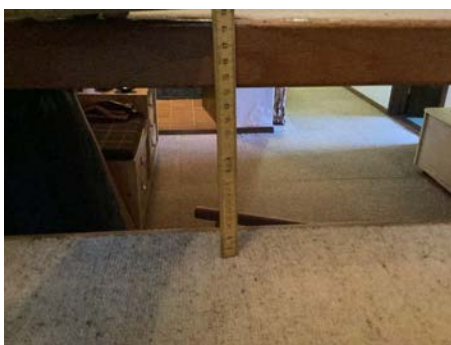
Stor åpning mellom trinn
