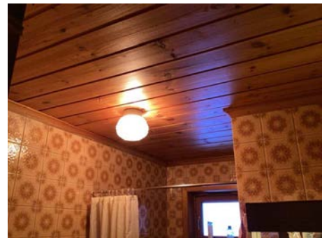
Rommet ventil i vindu
