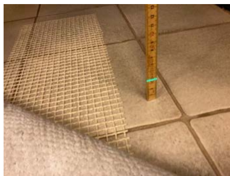
Måling 80 cm fra sluk målt 35mm
