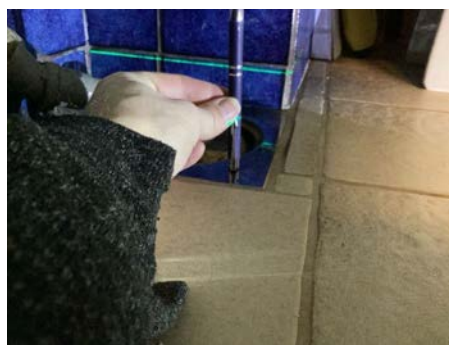
Måling ved sluk 45 mm til laser
