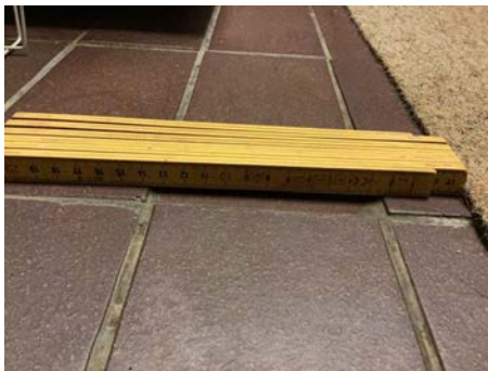
Sprang mellom fliser
