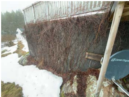
Forstøtningsmur i betong.
