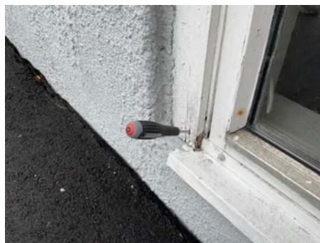
Mindre råteskade.
