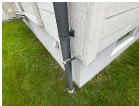
Mindre råteskade.
