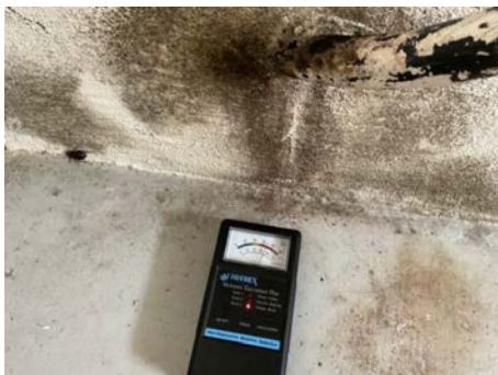
Søk med fuktindikator.
