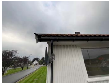
Renne og nedløp.
