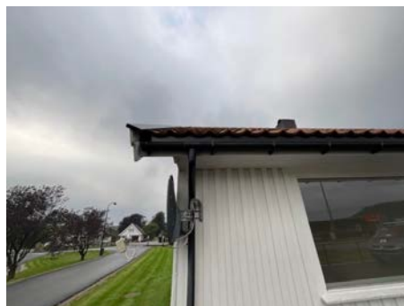
Renne og nedløp.
