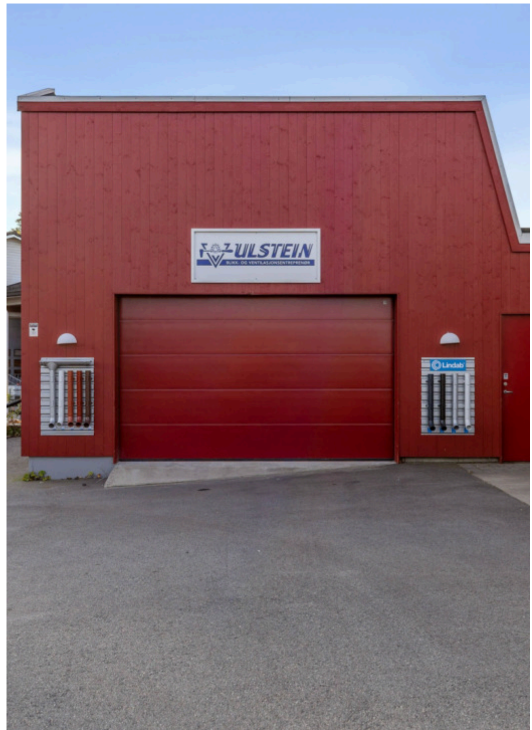
Tidligere snekkerverksted som ble påbygd i 2017.
