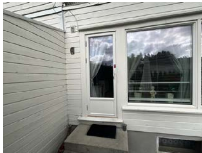
Nyere balkongdør fra stue.
