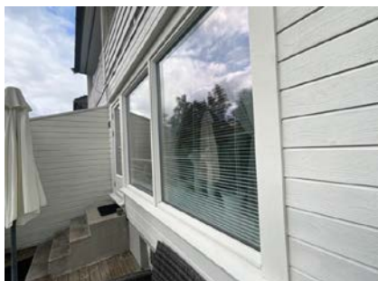
Vinduer i stue av nyere dato.
