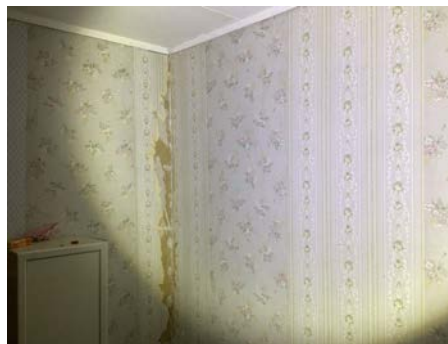
Fuktskader på vegg
