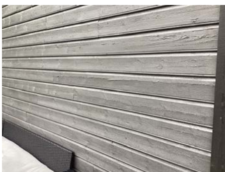
Kledning sprekker
