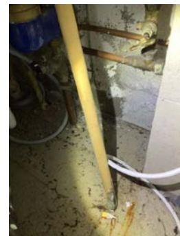
Eldre sluk med membran, membran er ikke under klemring
