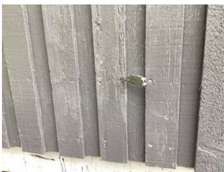
Kledning er værslitt og har sporadisk råteskader
