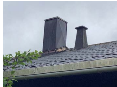
Maling / film flasser av på pipehatt
