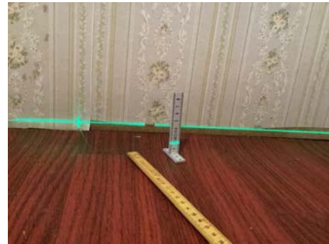
Måling på 2 meter soverom underetasje
