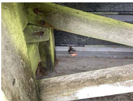
Utett beslag, fare for lekkasje
