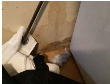
Fuktskader på vegg
