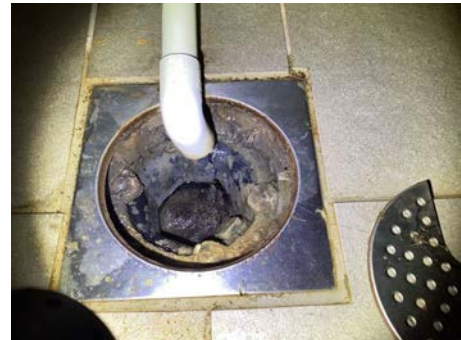
Eldre sluk med membran, membran er ikke under klemring
