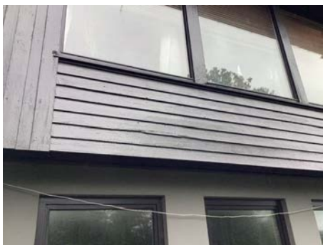
Kledning er værslitt og har sporadisk råteskader
