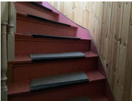
Skjevheter i trinn og knirk i trinn
