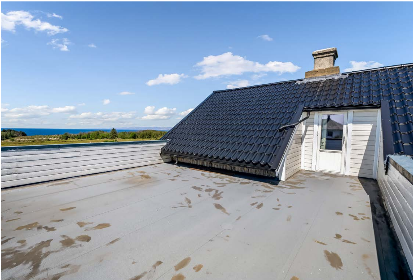
Takterrasse med inngang til boligens loft.
