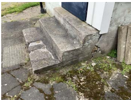
Trapp mangler rekkverk
