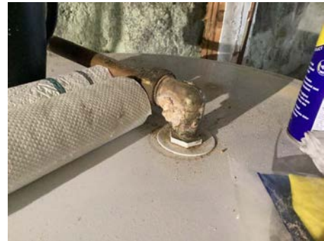
Korrosjon på kobling
