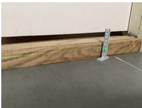
Måling ved terskel
