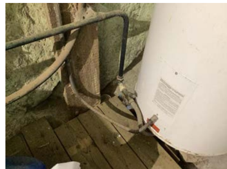
Korrosjon på kobling
