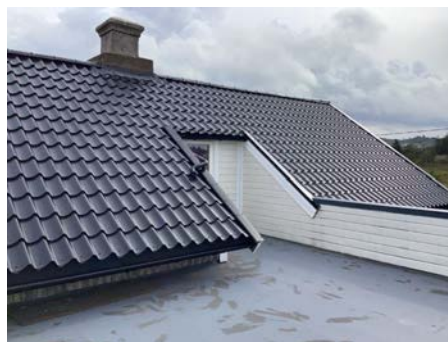
Taktekking av nyere dato
