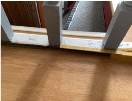
Åpninger er større enn dagens krav
