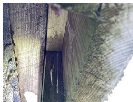
Lusing med lite ventilering
