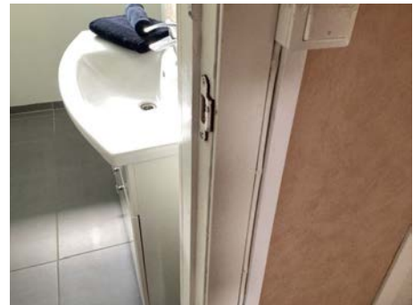
Skjevheter i karm, låsekammer er justert ut
