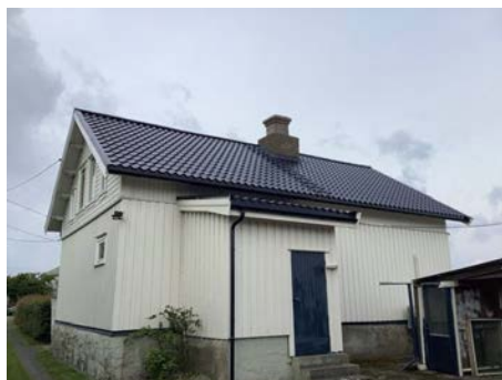
Taktekking av nyere dato
