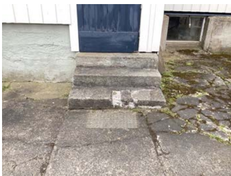
Trapp mangler rekkverk
