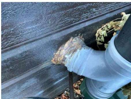
Fugetting rundt gjennomføring for avgassrør til forbrenningstolett.
