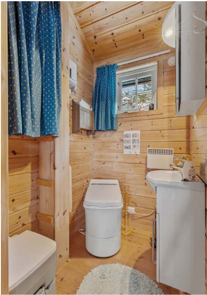
Toalettrom: Servantinnredning og forbrenningstolett
