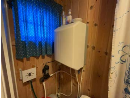
Vegghengt varmtvannsbereider i stellerom / bad.
