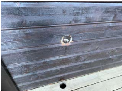
Fugetting rundt gjennomføring for avgassrør til forbrenningstoalett.
