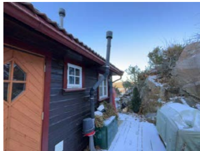
Utvendig avgassrør fra forbrenningstolett.
