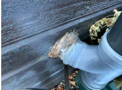
Fugetting rundt gjennomføring for avgassrør til forbrenningstoalett.
