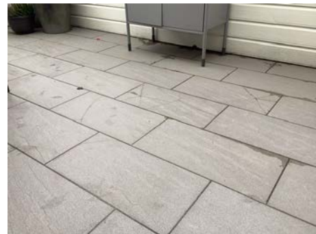
Flere fliser har sprekke og bom
