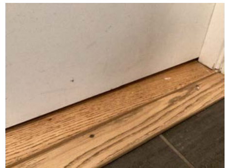
Tilluftspalte under dør
