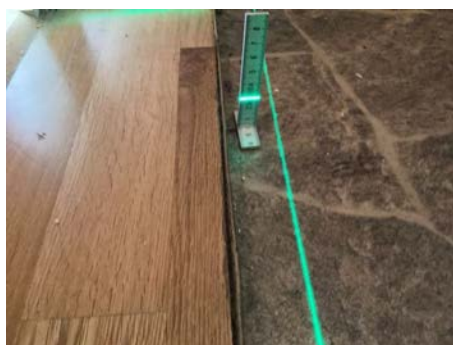
Måling ved terskel
