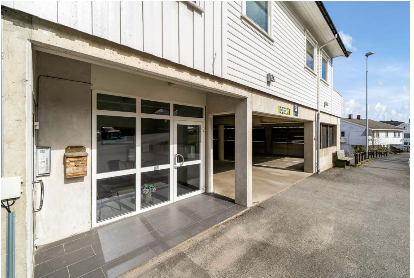
Inngangsparti med callinganlegg.
