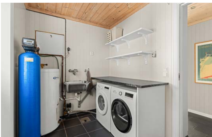
Vaskerom i 1. etg
