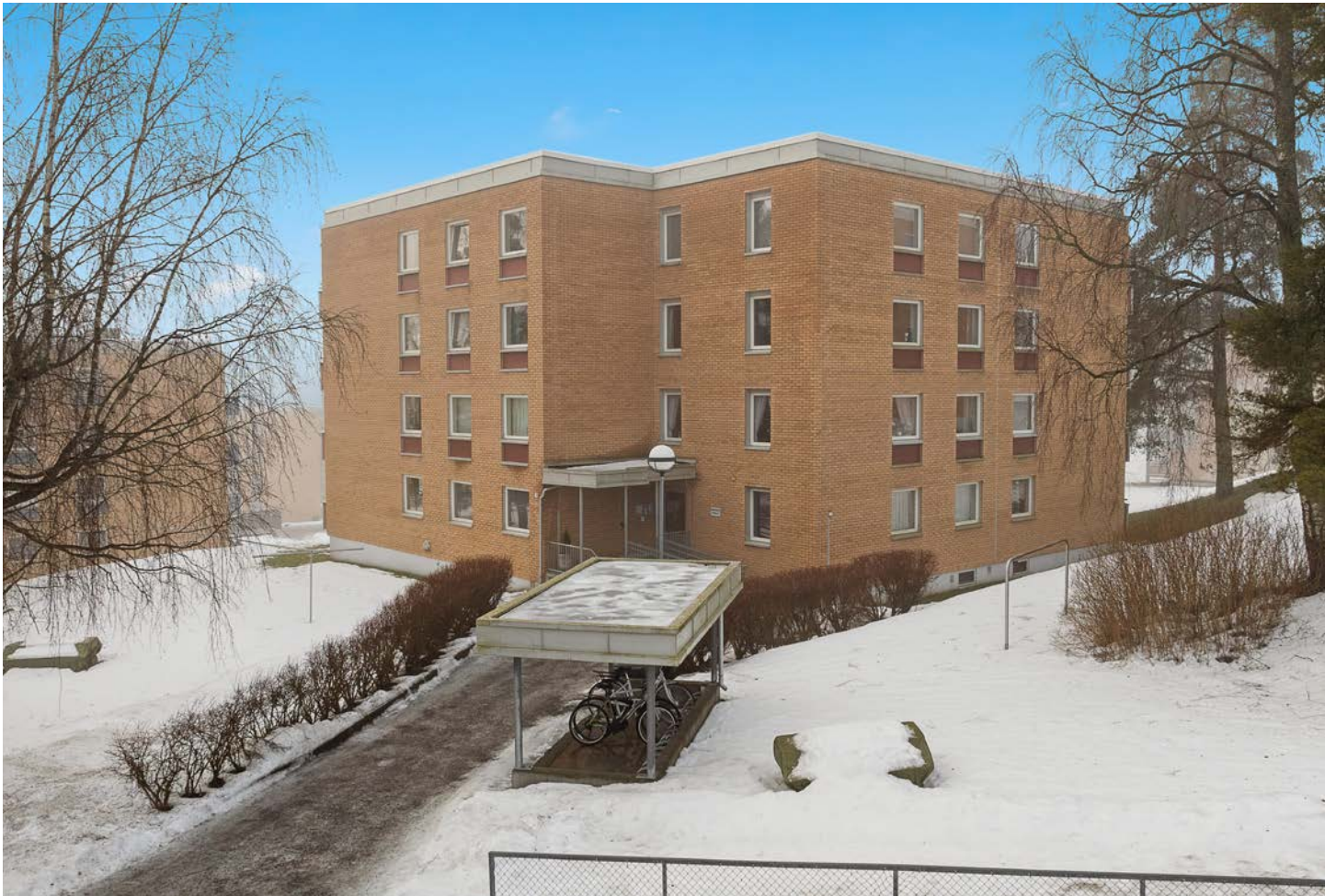
Borettslaget har fine fellesarealer, og har blant annet montert digitale dørlåssystemer, balansert ventilasjon og har oppgradert badrom
