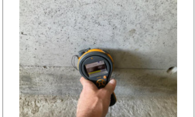
Fuktmåling i garasje. Ingen unormale utslag registrert
