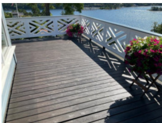
Terrasser med rekkverk og toppdekke av treverk.
