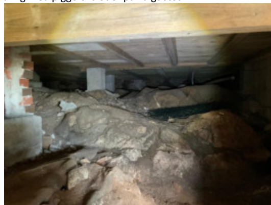
Deler av krypkjeller har lav høyde og dermed kun kontrollert fra avstand med lommelykt
