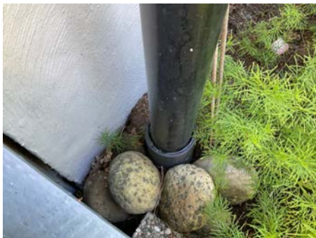
Taknedløp ledes til drens på bakside
