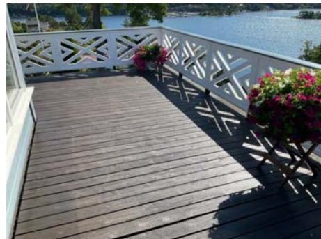
Terrasser med rekkverk og toppekke av treverk.
