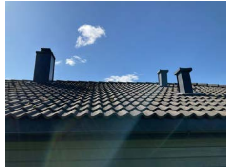
Pipe og luftinger over tak er helbeslått
