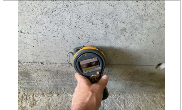
Fuktmåling i garasje. Ingen unormale utslag registrert
