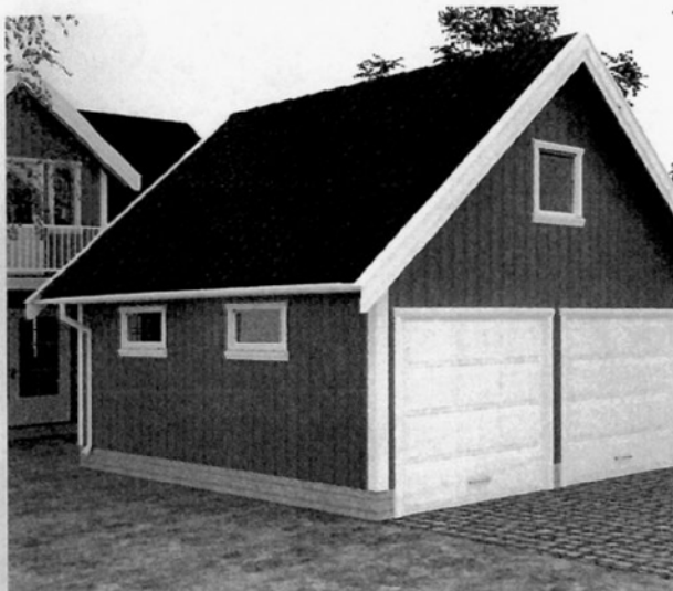
Garasje med stående kledning
