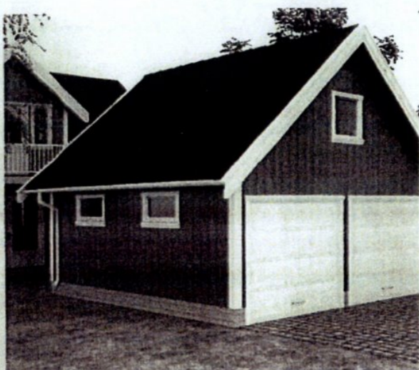
Garasje med stående kledning
