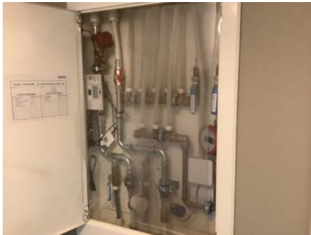
Fordelerskap til røropplegget.
