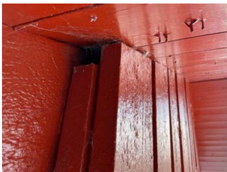
Bilde viser eksempel på åpning i kledning hvor mus kan krype inn.
