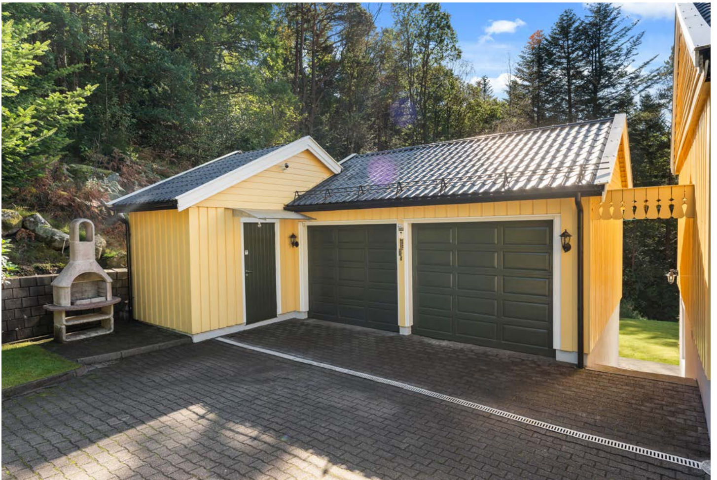
Dobbel garasje + verkstedrom/bod.
