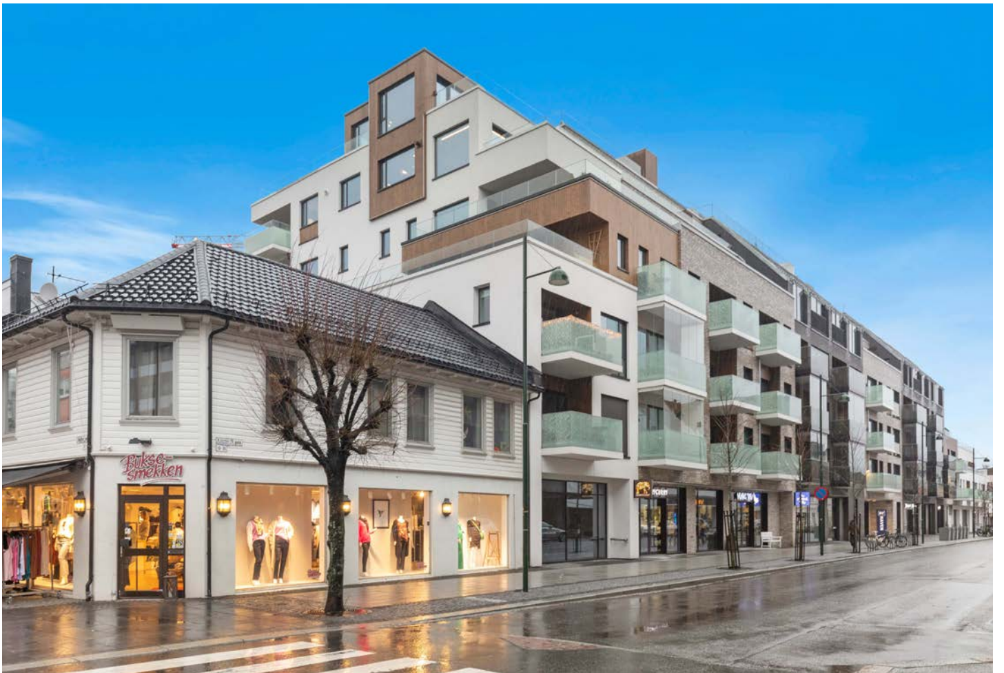
Fasade. Leiligheten ligger flott til i de to øverste etasjene
