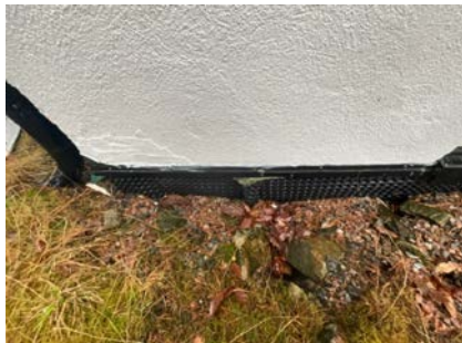
Synlig utvendig fuktsikring på deler av murer i bakkant av bolig.
