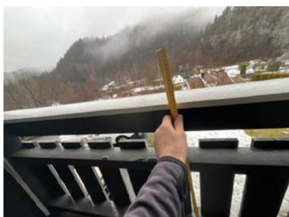
Rekkverkshøyde på veranda ut fra stue på 0.9
