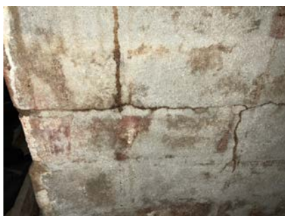
Noe sprekker i pipe på kaldtloft.
