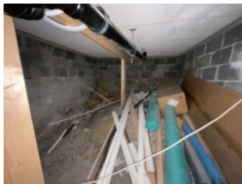
Oversikt av krypkjeller under bad
