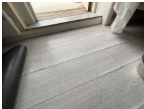
Fuktskadet gulv
