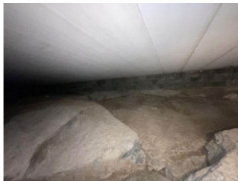
Oversikt av krypkjeller under stue del
