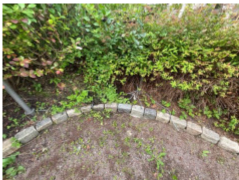
Det er montert utelamper, men disse har aldri vært tilkoblet ifølge eier. El sjekk anbefales.
