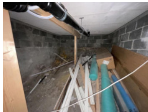
Oversikt av krypkjeller under bad
