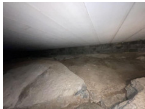
Oversikt av krypkjeller under stue del
