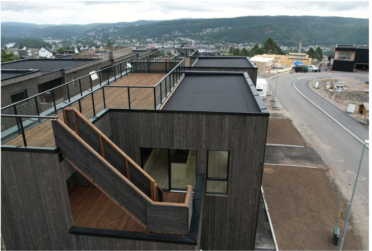
Takterrasse i Prestekragevegen 19.
