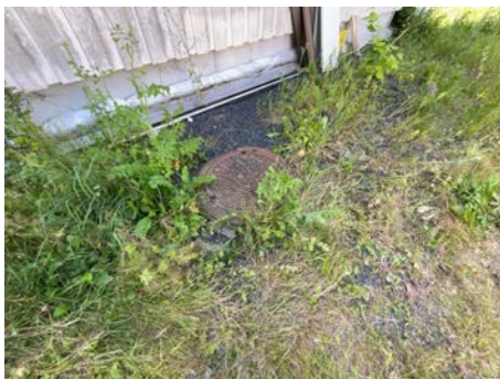
Septiktank i betong.
