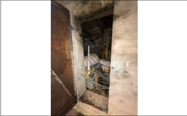
Utsnitt rom under inngangsparti bak grunnmur mot en natursteinsmur.
